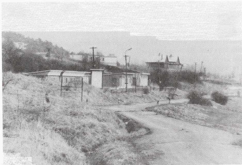
Obr. 5. Zosuvom porušená cesta v rekreačnej oblasti nová Keľča.
